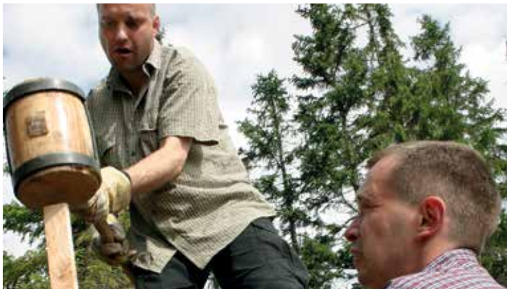
Errichten von Sperren
