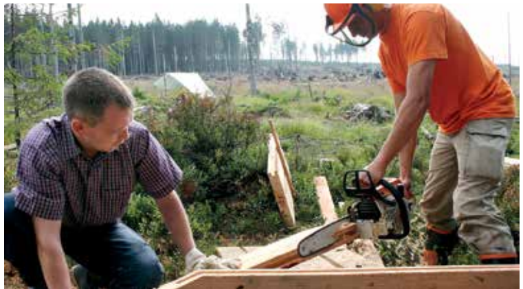
Anspitzen der Pfähle
