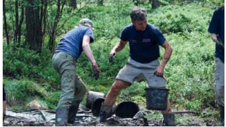
Entwässern der Gräben
