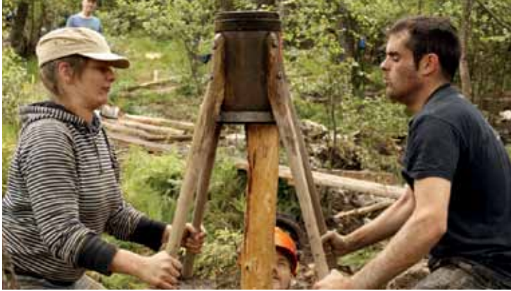
Einschlagen von Pfählen
