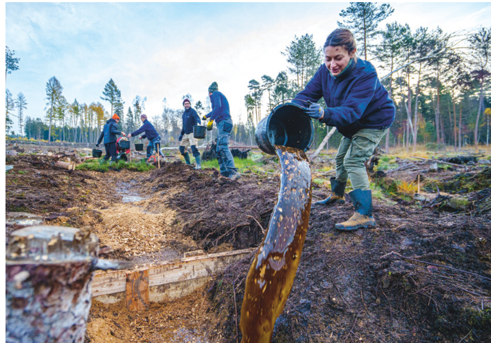
Ingenieurskunst und krafvoller Workout: Grabenverbauungen zur Wiedervernässung von Mooren
