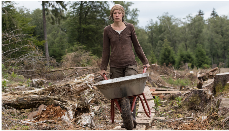
Verfüllungsmaterial wird herbeigeschafft.
