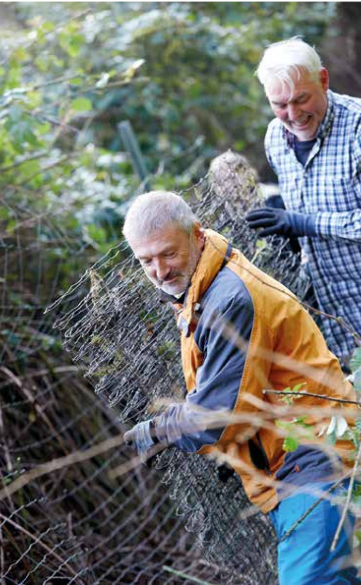
Zaunabbau am Einsatzort Schaalsee
